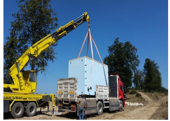
Vinç ile montaj yapılması
