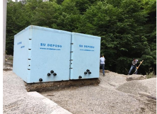
Zeminde ince malzeme ile tesfiye yapılmalıdır
