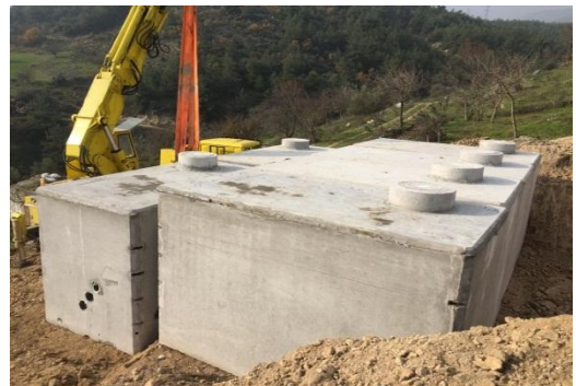
100 m3 Depo Sakarya Uygulaması
