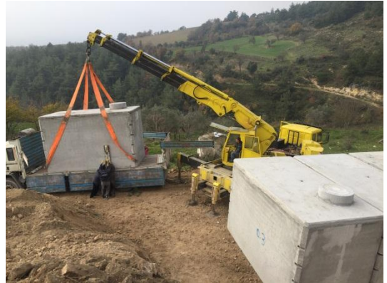
Vinç ile montaj yapılması
