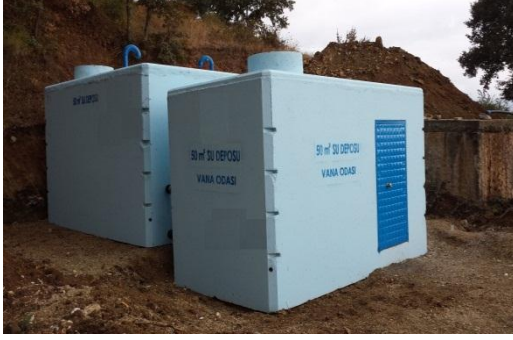
50 m3 Depo Sakarya Uygulaması
