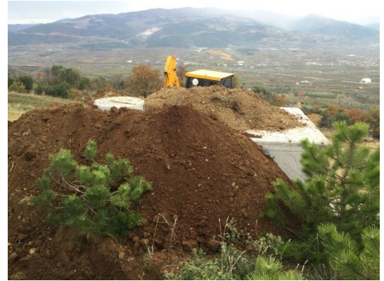
çıkan harfiyatla örtülmesi
