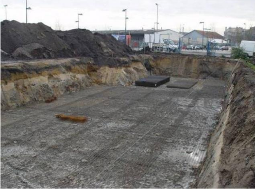
Zeminde iyileştirme yapılmalıdır
