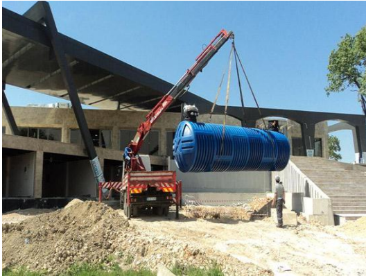
Vinç ile montaj yapılması
