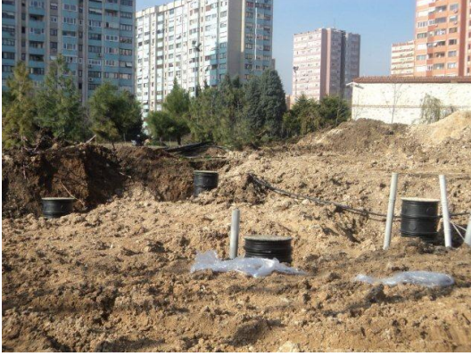
Yataklama malzeme ile toprak örtü yapımı
