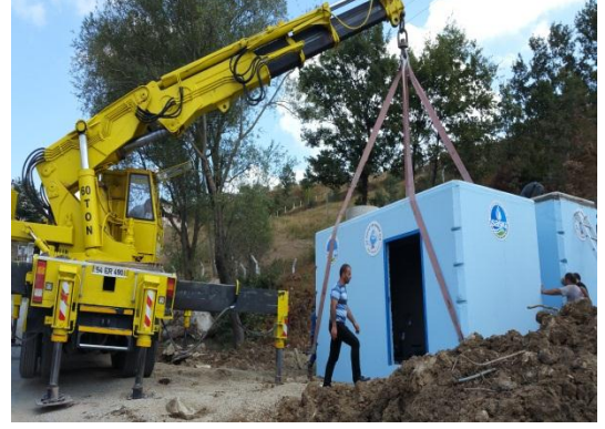
Vinç ile montaj yapılması
