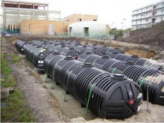
Zeminde iyileştirme yapılmalıdır
