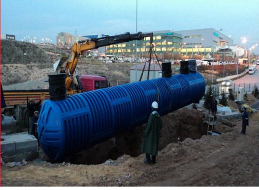
Vinç ile montaj yapılması
