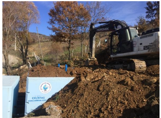
toprak örtü yapımı
