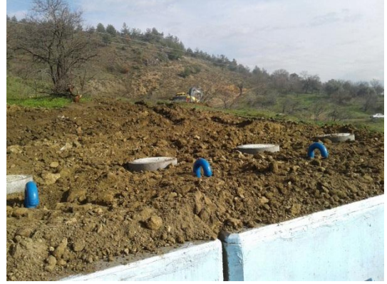
Yataklama malzemesiz toprak örtü yapımı
