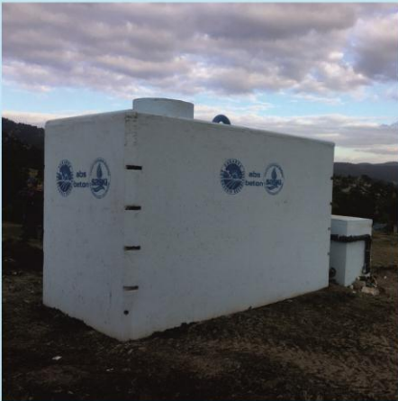
25 m 3 Su Deposu Montajı
